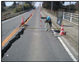
道路 災害調査
